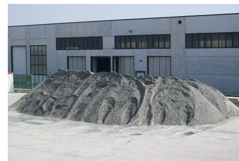
Sabbia stoccata in impianto utilizzata per il dreno della vasca EV5
