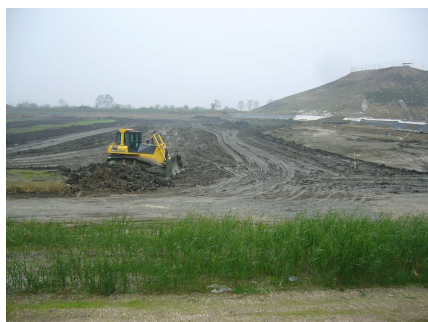
Argilla in fase di stesa
