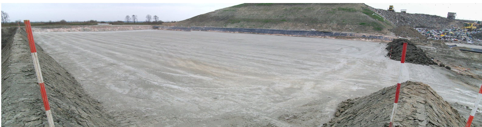
6/03/2012: vasca EV5 bentonizzata
