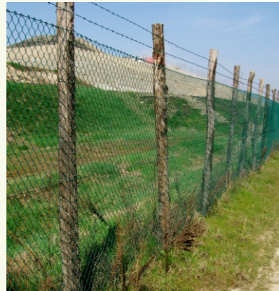
Recinzione perimetrale lungo il lato est dei lotti B ed E
