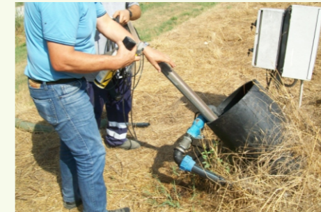
Misura dei livelli di percolato nei pozzi di raccolta
