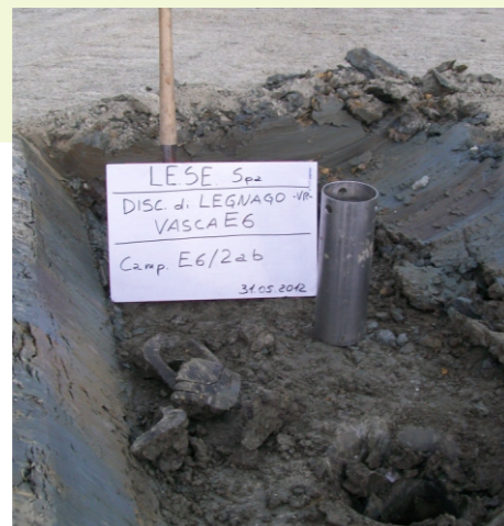
Campionamento dell'argilla dal fondo della vasca EV6
