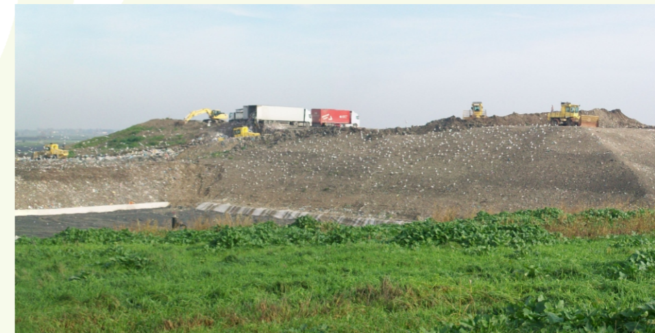
Fasi di coltivazione del rifiuto sul lotto E
